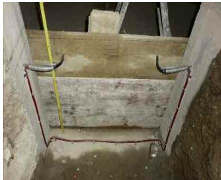
**Ein Injektschlauch dient zur Abdichtung und Auffüllung von Hohlräumen nach dem Betonieren.**
