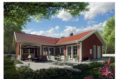
Leben auf einer Etage: Eingeschossige Schwedenhäuser im Bungalow-Stil sind besonders beliebt.
