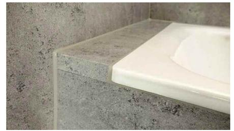
**Ecken lassen sich mit den Aluverbundplatten glatt und bündig verkleiden.**
