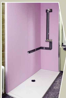
Duschwanne setzen und Wandmodule montieren
