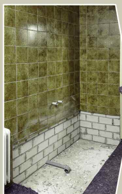
Demontage der Badewanne, Ausgleich des Untergrundes
