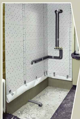
Abdichtung anbringen und Rohrleitungen installieren
