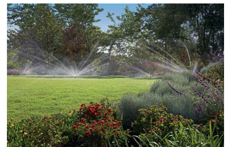
Smarte Bewässerungsanlagen versorgen den Rasenteppich und die Beete automatisch nach Bedarf.
